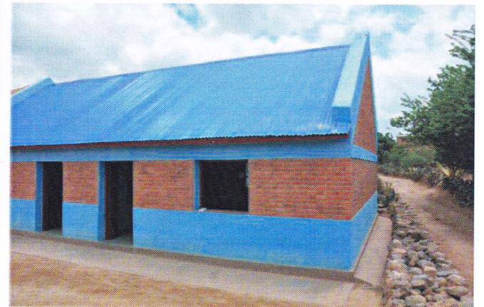
Le bâtiment achevé. Il s'adosse coté Nord au bâtiment construit en 2014. Le bâtiment vient donc en limite de propriété se terminer près de la piste (à droite). Le choix des tôles a été effectué par les parents d'élèves. Le chaume local devient difficile à trouver et de plus, il doit être renouvelé tous les six ans environ.
