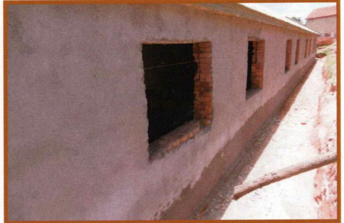
Dans chaque classe, préparation de la charpente pour recevoir un nouveau faux plafond en bois. L'enduit ciment des murs extérieurs a bien séché. Les huisseries bois sont posées (ci-dessous). Un petit auvent en béton abrite les volets bois.
