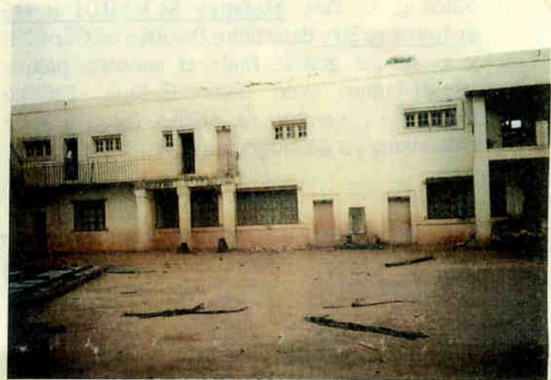
L'école après le cyclone
