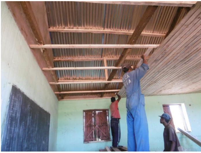
A l'intérieur : réalisation du faux plafond en voliges bois.
