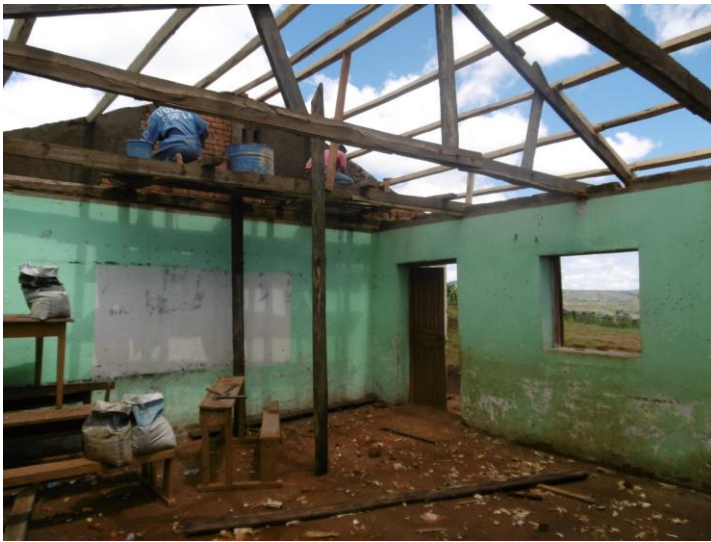
La charpente est totalement remaniée et fixée par des accroches acier afin d'éviter d'être emportée par les vents violents. Les matériaux continuent d'être livrés en bordure de piste. Il reste 1 h.30 d'acheminement jusqu'à l'école.
