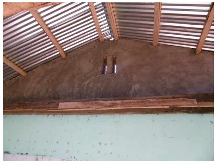
Les premières tôles sont posées et les enduits intérieurs sont repris, même au dessus des faux plafonds afin d'étanchéité.
