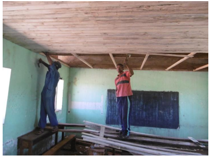
A l'intérieur : réalisation du faux plafond en voliges bois.
