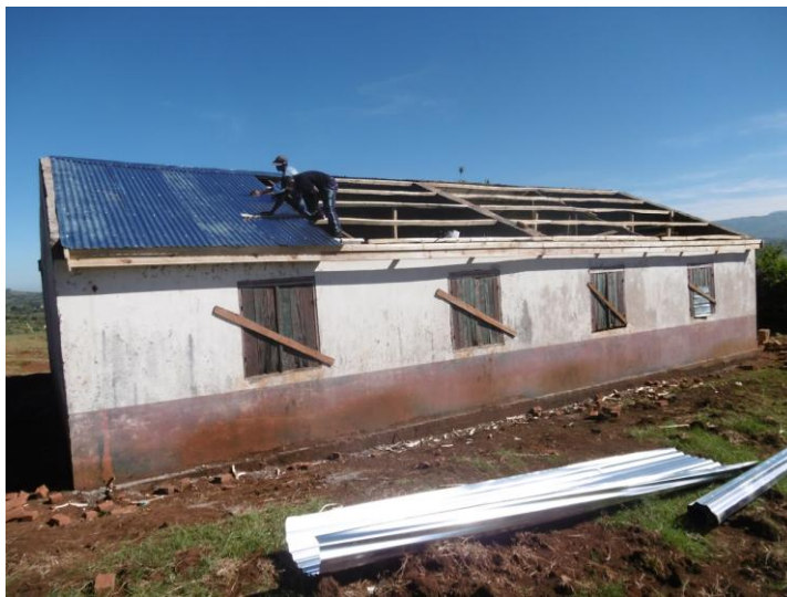
Les premières tôles sont posées et les enduits intérieurs sont repris, même au dessus des faux plafonds afin d'étanchéité.
